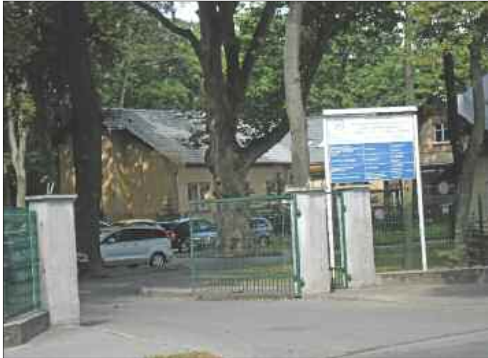
PWiK kończy powoli realizację wartego ponad 221,6 mln zł projektu.
