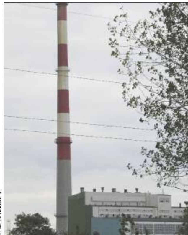
W gorzowskiej elektrociepłowni już niedługo przestaną używać węgla
