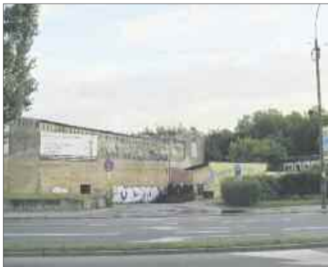
1. Ta rudera od wielu już lat straszy w centrum miasta, przy ul. Strzeleckiej; niegdyś leżakownia browaru braci Gross i obok stara, z czasów PRL, Centrala Rybna. Ale ostatnio pojawiła się nadzieja dla tego miejsca. Urząd Miasta porozumiał się z właścicielami i ma tu powstać nowy kompleks handlowo-usługowy. Coś powoli zaczyna dziać się w tej sprawie.
