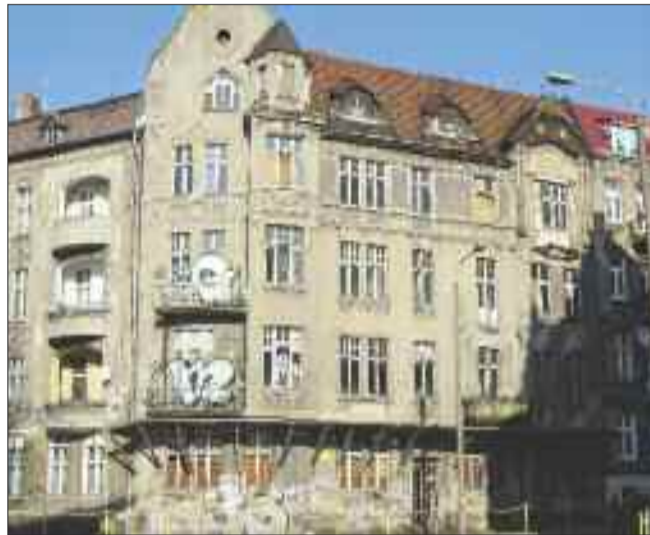
5. Wpisana do rejestru kamienica przy Łokietka 17 to kolejny przykład tego, że magistrat nie umie sobie poradzić z prywatnymi właścicielami. Budynek ma 112 lat. Straszy dziś nie tylko zniszczeniami, ale i zagrożeniem dla pozostałych budynków w tej pierzei. I raczej nie ma pomysłu, co z tym niszczącym zabytkiem zrobić, ani jak zmusić właścicieli o zadbania o niego.
