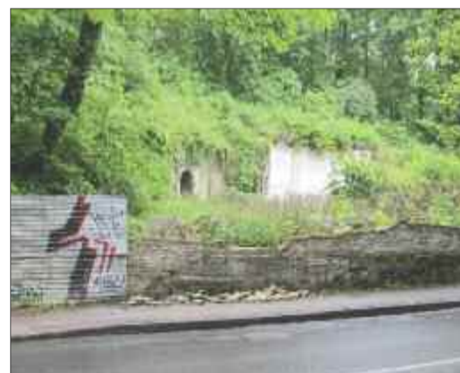
9. Piwnice przy Walczaka to pozostałość po leżakowni browaru Ehrenberga z XIX wieku. Od lat własność prywatna. W planach było tu postawienie między innymi ośrodka dla młodzieży, wielofunkcyjnej kamienicy, a najnowszy właściciel deklarował otwarcie stylowej knajpki. Nic z planów nie wyszło, miejsce straszy, jest niebezpieczne i wystawione na sprzedaż. Chętnych jakoś jednak brak.
