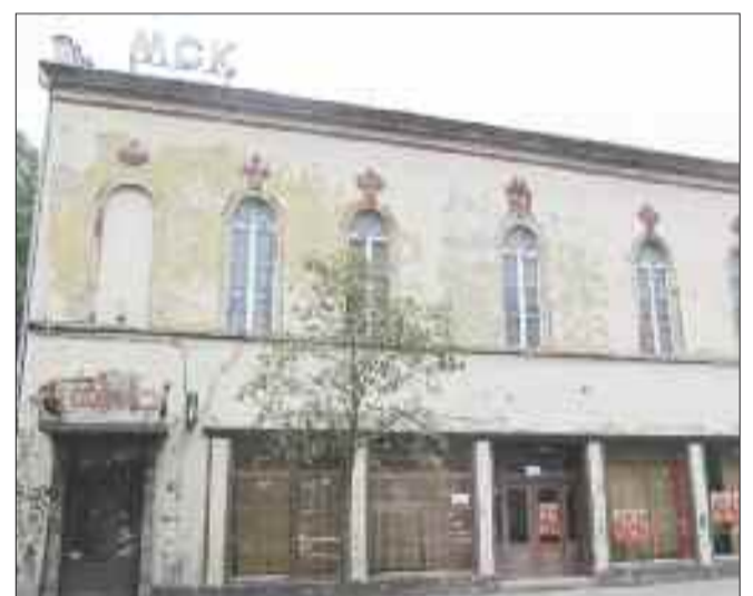
12. Fasada Miejskiego Centrum Kultury przy ul. Drzymały woła o pomstę do nieba. Oblężona płatami farba, luszczący się tynk powodują, że budynek przypomina wszystko, ale nie sztandarową placówkę kultury. Decyzją straży pożarnej kilka lat temu zamknięto Klub Magnat, bo nie spełniał zasad bezpieczeństwa. Jeśli nic się nie zmieni, w najbliższej przyszłości taki los może spotkać cały budynek.
