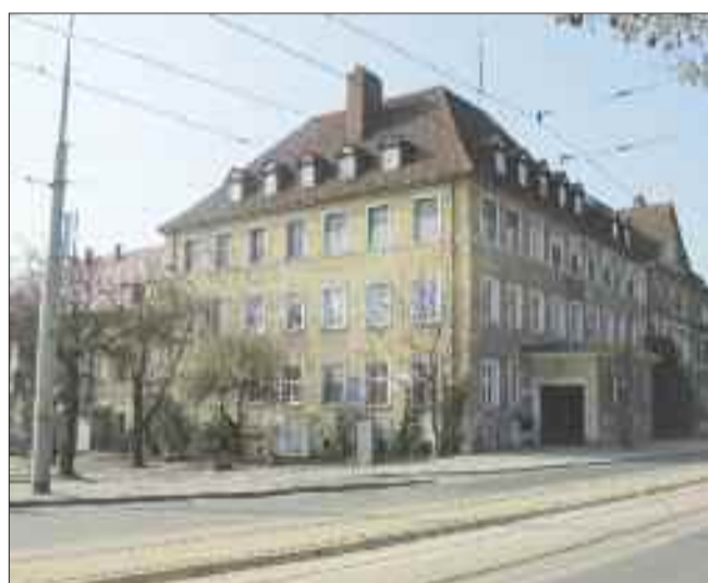
11. Zespół dawnego Szpitala Miejskiego znajduje się pomiędzy ulicami Warszawską i Szpitalną. Najstarsza część szpitala zajmuje działkę przy ulicy Szpitalnej. To eklektyczny, dwupiętrowy budynek z klinkierowej cegły zbudowany w 1848 r. Po wojnie był głównym miejskim szpitalem, zamknięty w 2008 roku. Najnowsza koncepcja jest taka, że powstanie tu centrum kształcenia technicznego.
