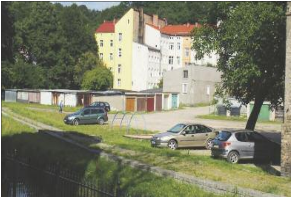
Projekt zakłada remont nie tylko części wspólnych kamienicy, ale jeszcze stworzenie wspólnej przestrzeni rekreacyjnej, jaką może być właśnie zrewitalizowane podwórko.
