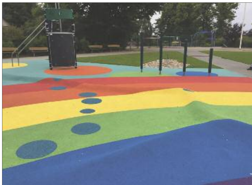
Taki plac zabaw (wybudowany w Szwecji) jest nie tylko atrakcyjny od strony estetycznej, ale przede wszystkim spełnia normę tzw. wysokości bezpiecznego upadku.
