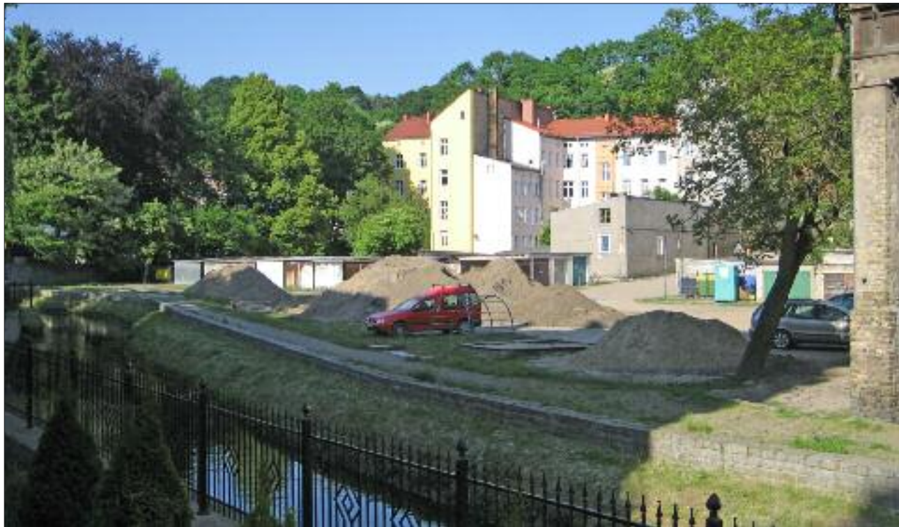
Zasadniczej przebudowie ulegnie m.in. podwórko w sąsiedztwie Kłodawki przy ul. Łokietka-Drzymały
