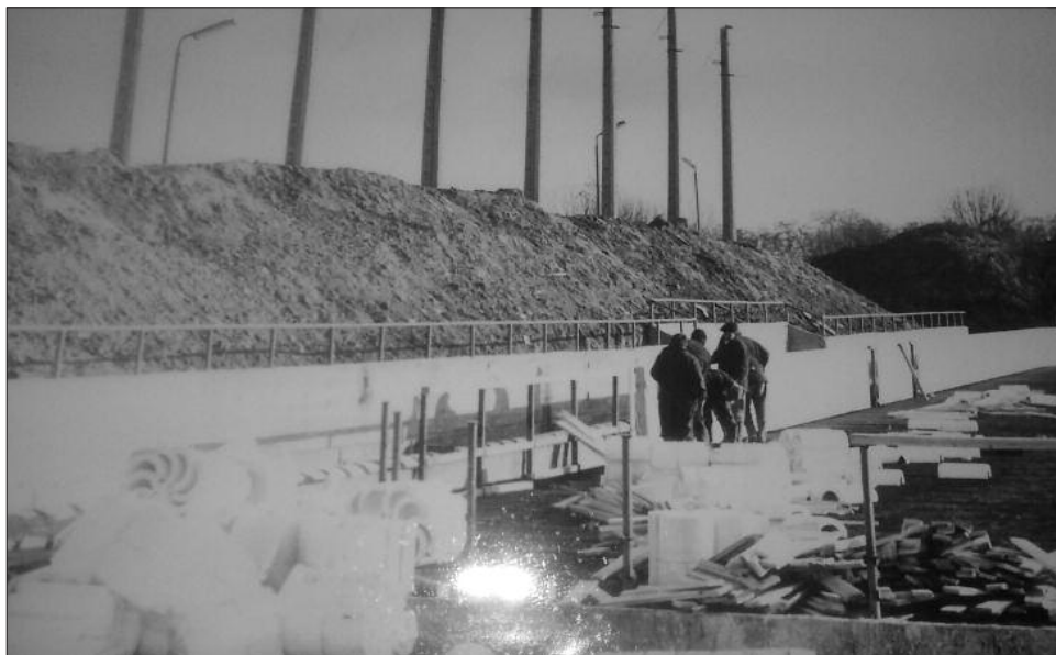
Lodostil budowała „Przemysłówka”, ale pomagali także hokeiści Stilonu.
