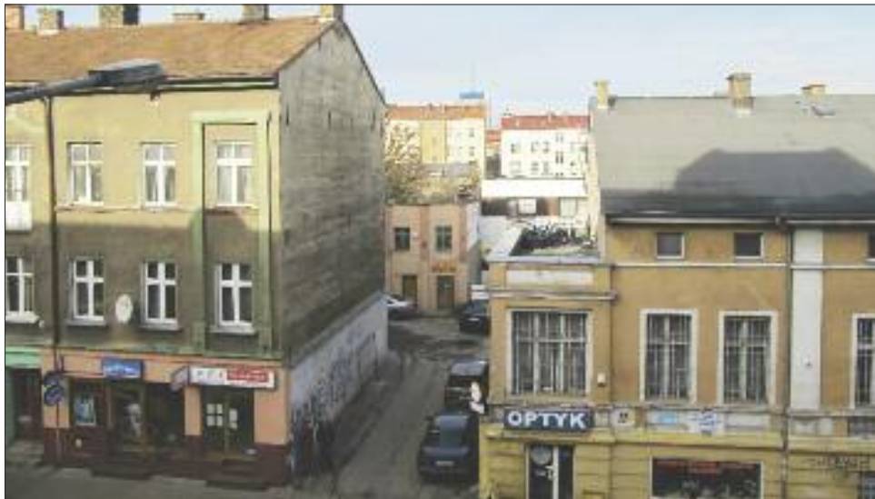
Przeglądy piwnic oraz sprawdzanie przewodów kanalizacyjnych, wodociągowych oraz kominowych przed zimą jest rutynowym działaniem ZGM
