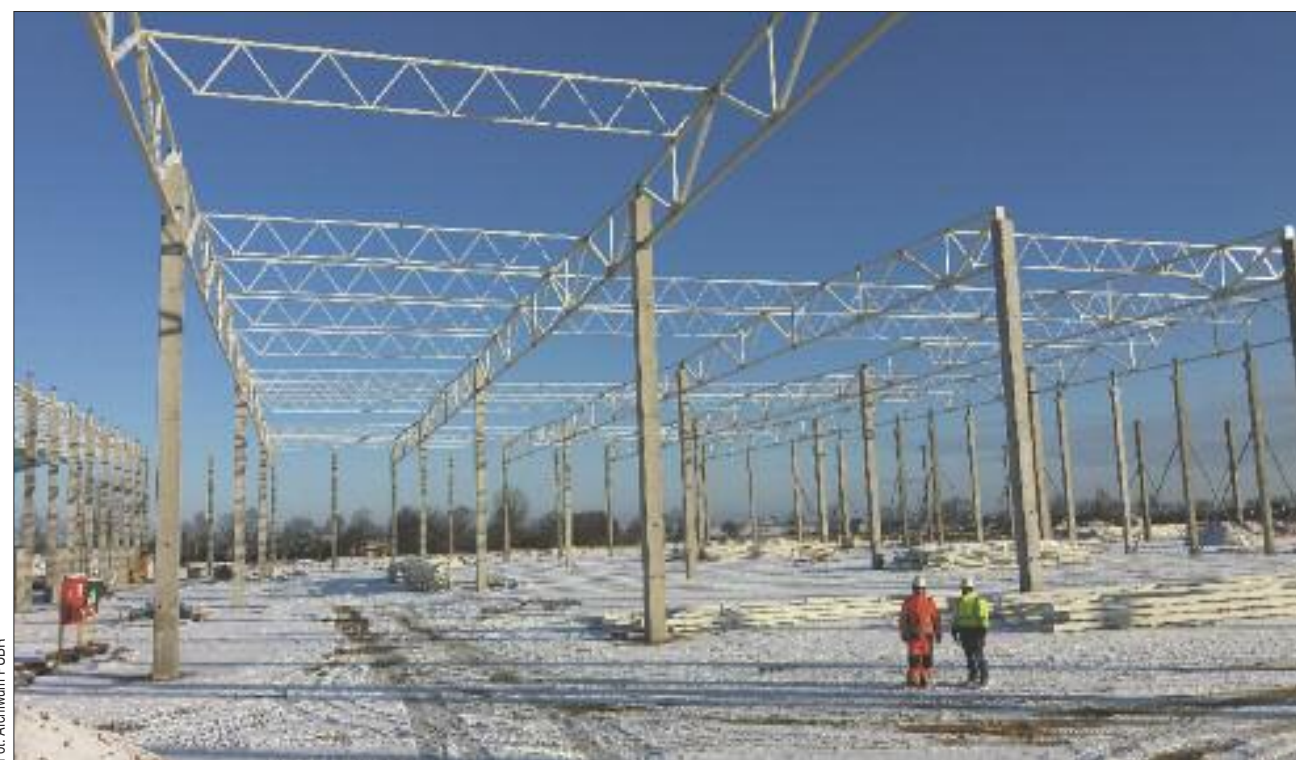
Materiały wyprodukowane w PUBR zostały użyte m.in. przy budowie Centrum Logistycznego Biedronki w Gorzowie
