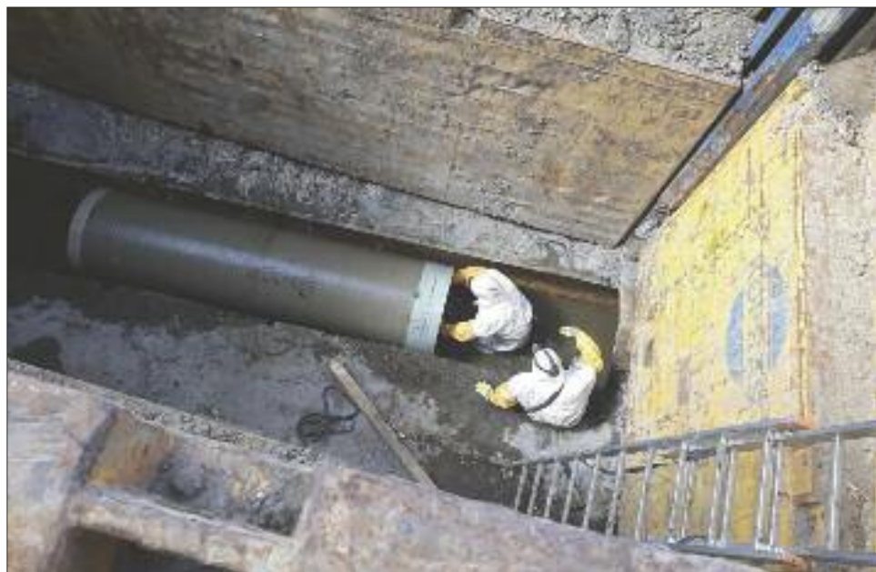
Modernizacja polega na renowacji starych kanałów sanitarnych
