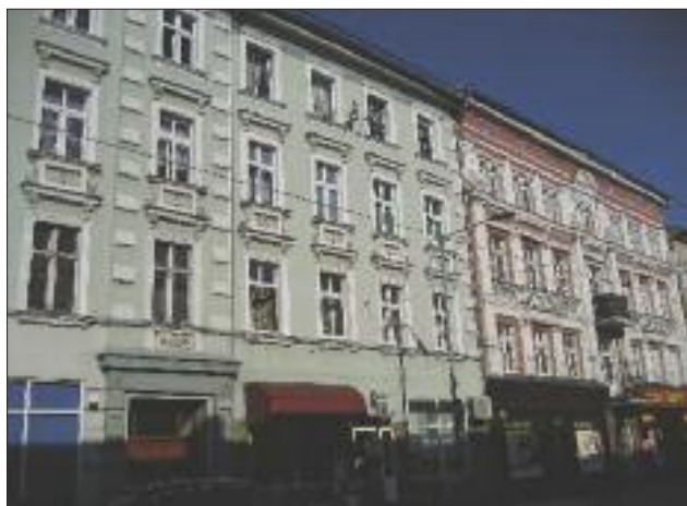
W zasobach ZGM szykują się w tym roku liczne prace remontowe
