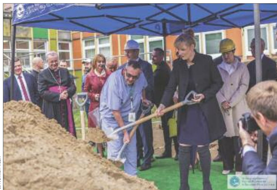
Budowa pawilonu dla Oddziału OIOM-u i hematologii rozpoczęła się
