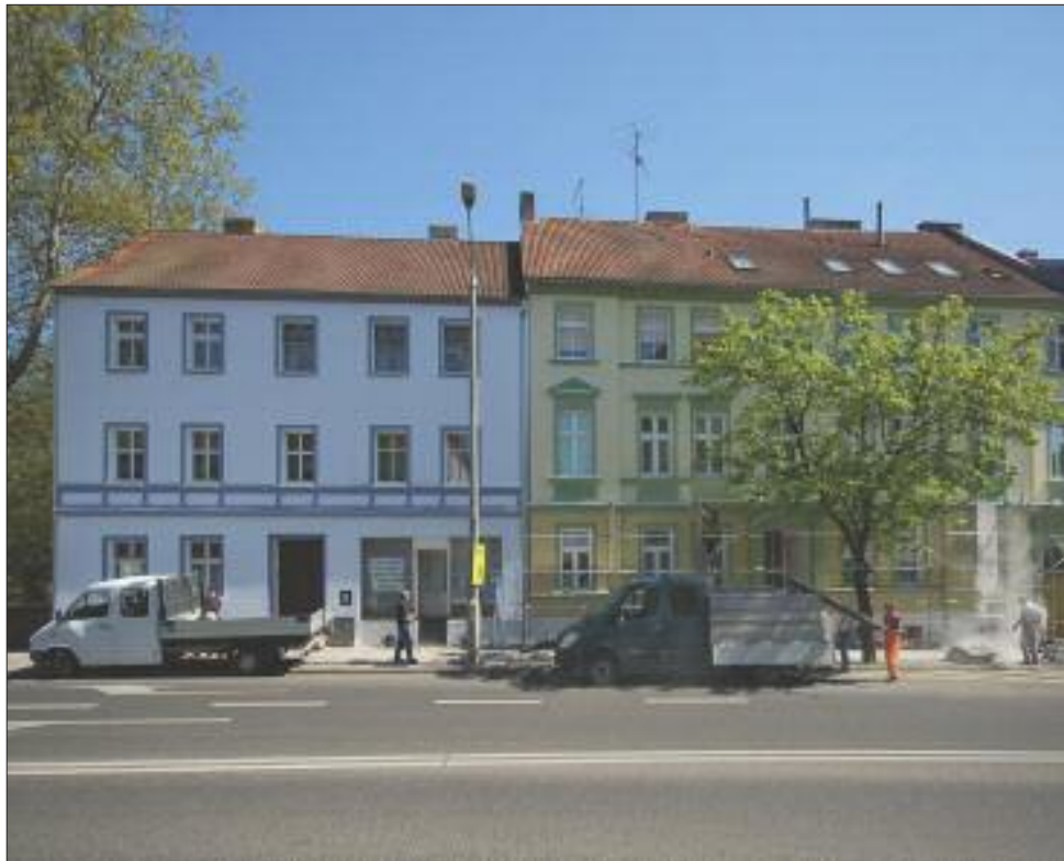
W mieście cały czas trwają remonty elewacji, dachów oraz różne prace konserwatorskie
