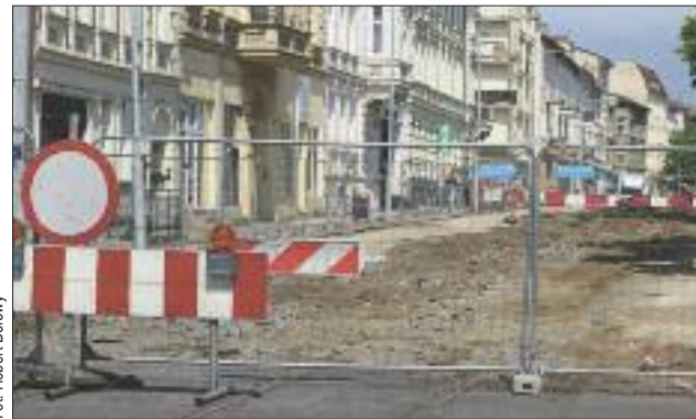
Na Chrobrego prace posuwają się w szybkim tempie
