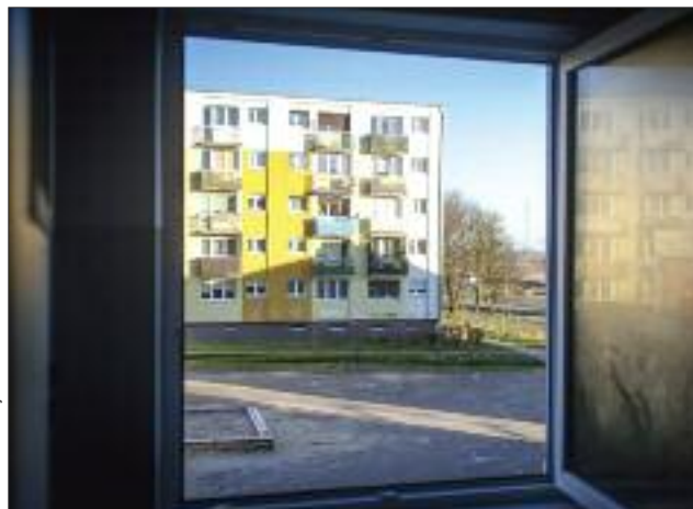
Remonty pięciu lokali socjalnych odbywają się dość kompleksowo
