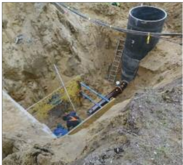
W ramach prac uporządkowano sieć wodociągową o łącznej długości 2,3 km
