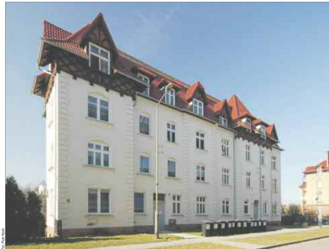
Niestety, budżetowych pieniędzy na remonty zabytkowych kamienic nie ma zbyt wiele.
