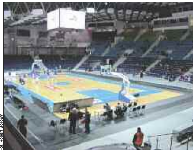
W Szczecinie wybudowano halę za sto milionów zł
