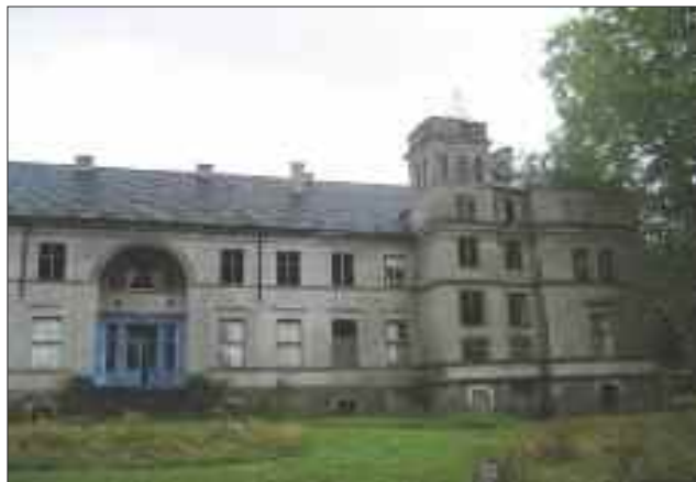
Dzisiaj pałac w Sosnach czeka na remont.
