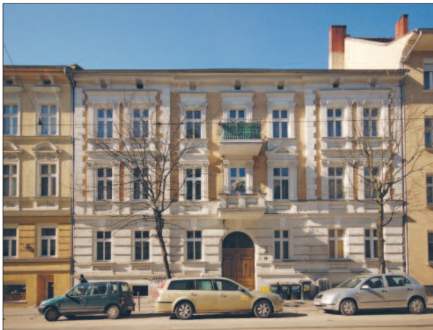
Większość kamienic administrowanych przez ZGM jest mocno nagryziona zębem czasu, ale część z nich odzyskała już dawny blask.
