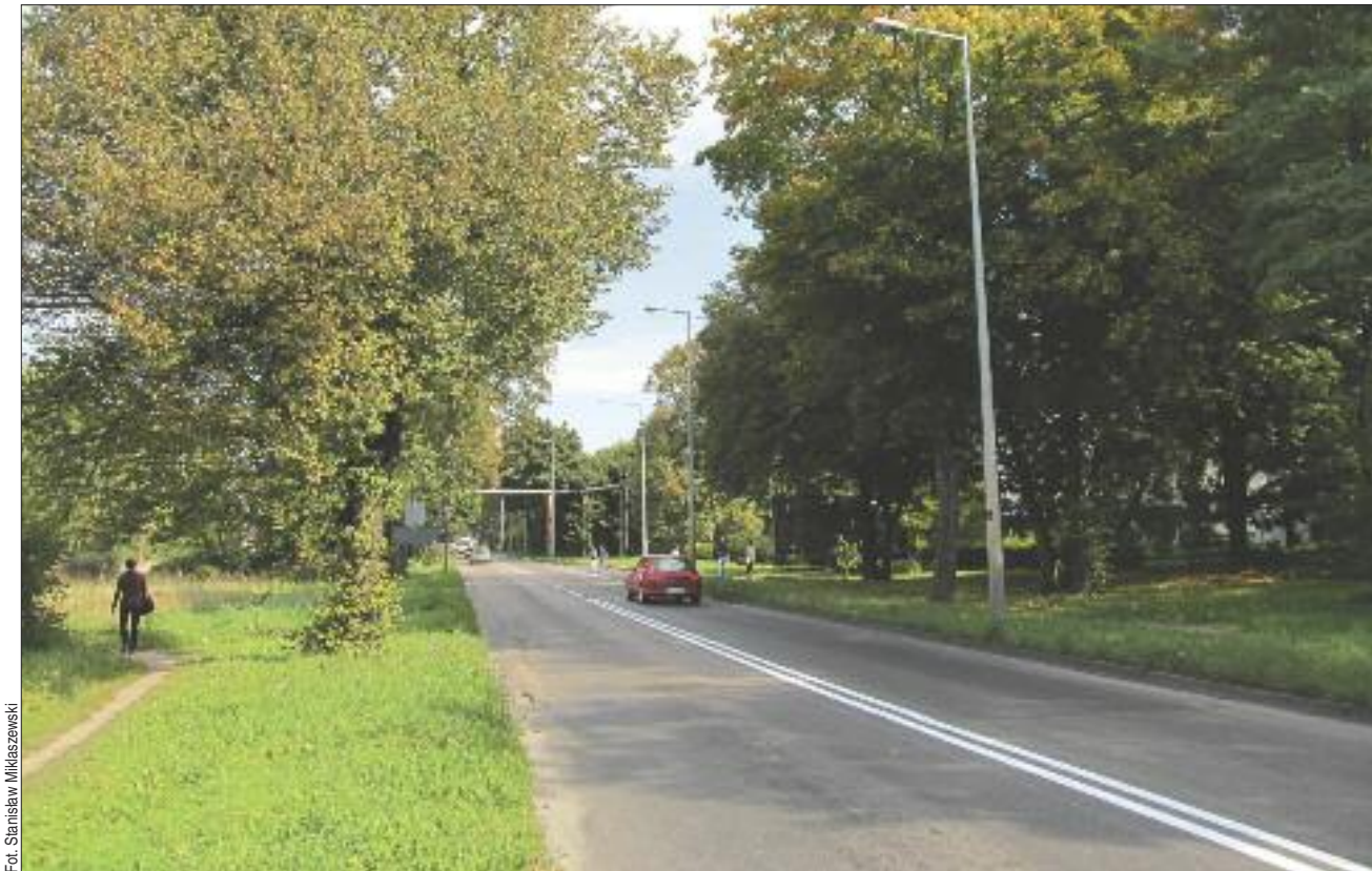
Modernizacja drogi krajowej nr 22 przy wylocie z miasta nie tylko ułatwi komunikację, ale także podniesie atrakcyjność znajdujących się tam terenów inwestycyjnych. Zyska na tym Gorzów, ale i sąsiednie gminy - Kłodawa oraz Santok.
