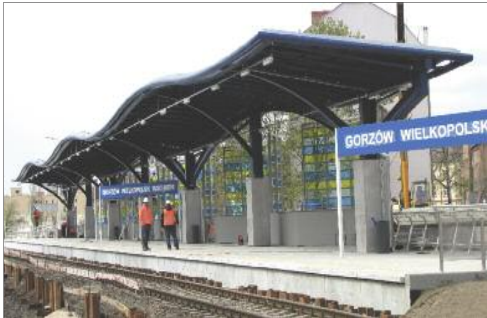
Prace na przystanku kolejowym przy Teatralnej trwały do ostatniej chwili.
