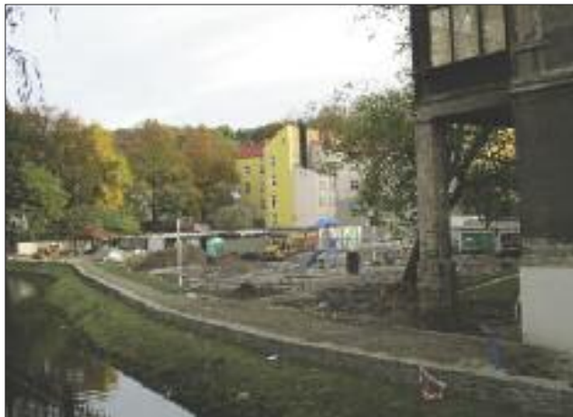
Na podwórku przy Kłodawce między ul. Łokietka - Drzymały widać już mały plac zabaw, altanki wypoczynkowe oraz śmieciową
