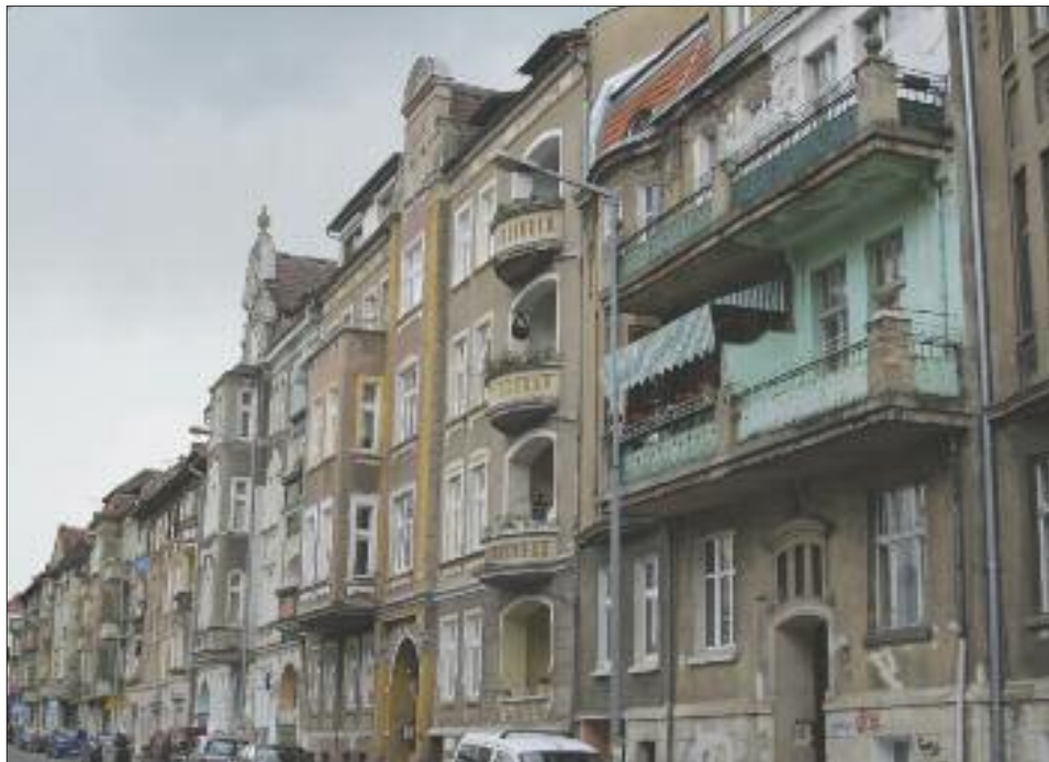
ZGM ma precyzyjnie rozpisany plan, gdzie i kiedy będzie remontować, naprawiać i rozbierać
