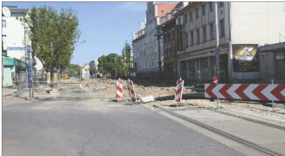
Remont ul. Sikorskiego urzędnicy magistratu mogą obserwować na żywo każdego dnia
