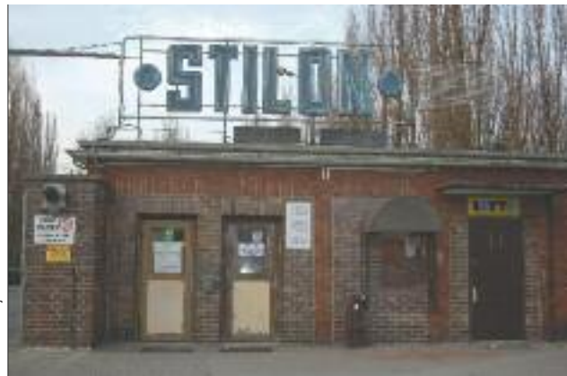
Tej zabytkowej portierni i bramy prowadzącej do Stilonu od strony ul. Pomorskiej nie udało się wcześniej uratować
