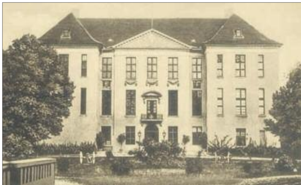
W zamku najważniejszymi pomieszczeniami były sala dworska oraz mieszcząca się nad nią sala odświętna wysoka na trzy kondygnacje.
