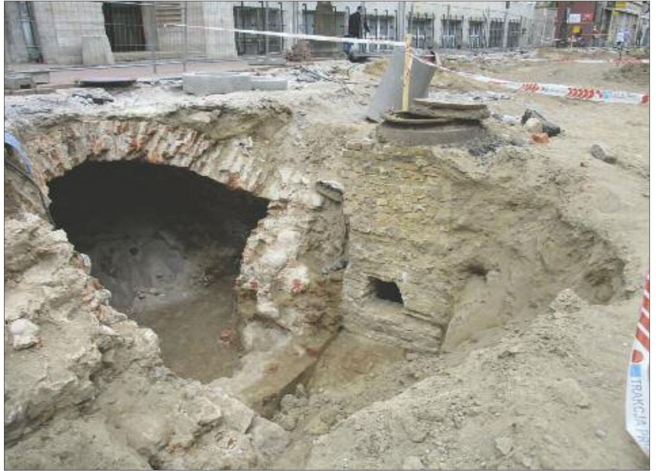
Wejście do XVIII-wiecznej piwnicy a po prawej XIX-wieczny kanał potoku Młynówka
