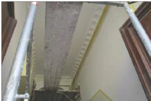
Stiuki i plafon ozdabiający lampę pojawił się na remontowanej klatce schodowej przy ul. 30 Stycznia
