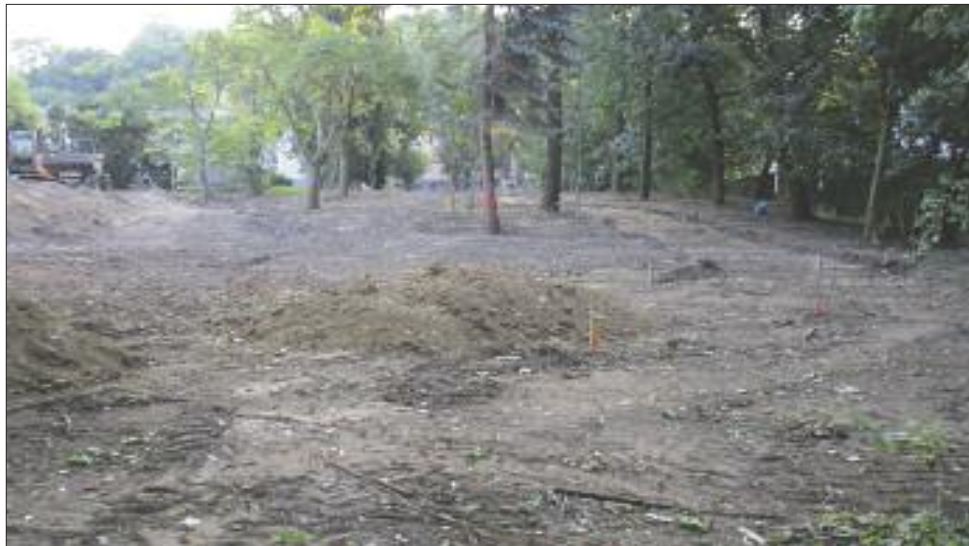
Wielki plac budowy, jakieś buldożery, spychacze, wydziabane drzewa...
