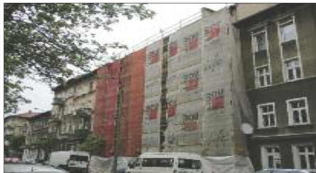
Już trwa remont fasady przy ul. Armii Polskiej
