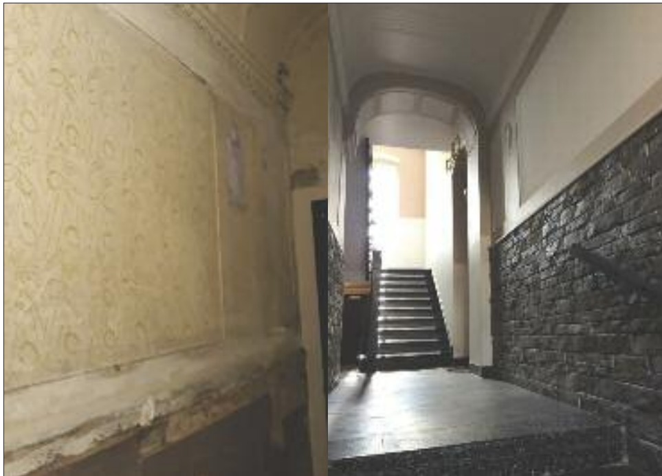
Klatka schodowa w kamienicy przy alei Konstytucji 3 Maja przed remontem i po remoncie
