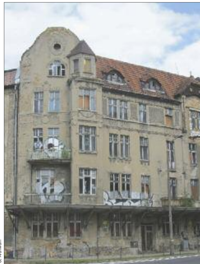
Najbardziej jaskrawym przykładem zaniechań właścicieli jest budynek przy ul. Łokietka 17
