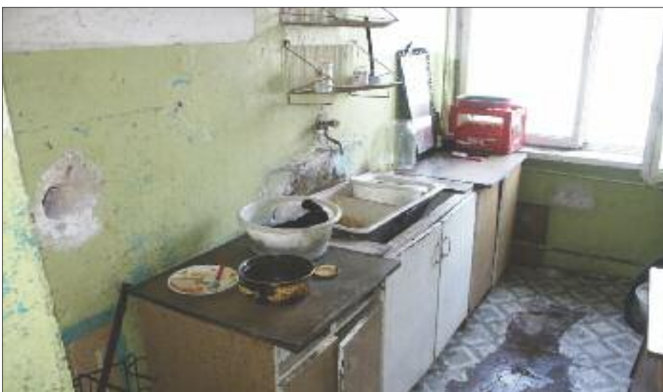
Wiele mieszkań przejętych od niesolidnych użytkowników wymaga gruntownego remontu
