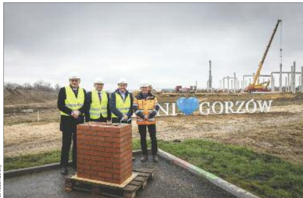
Tu wmurowano kamień węgielny pod budowę centrum logistyczno-przemysłowego Panattoni Park Gorzów
