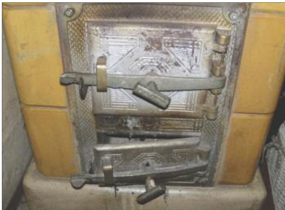
Stare piece wymienione będą na bardziej ekologiczne gazowe ogrzewanie etażowe
