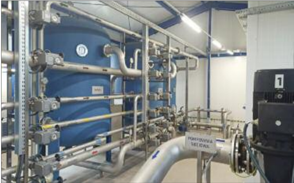
Stacja uzdatniania wody w Maszewie została poddana całkowitej niemal modernizacji
