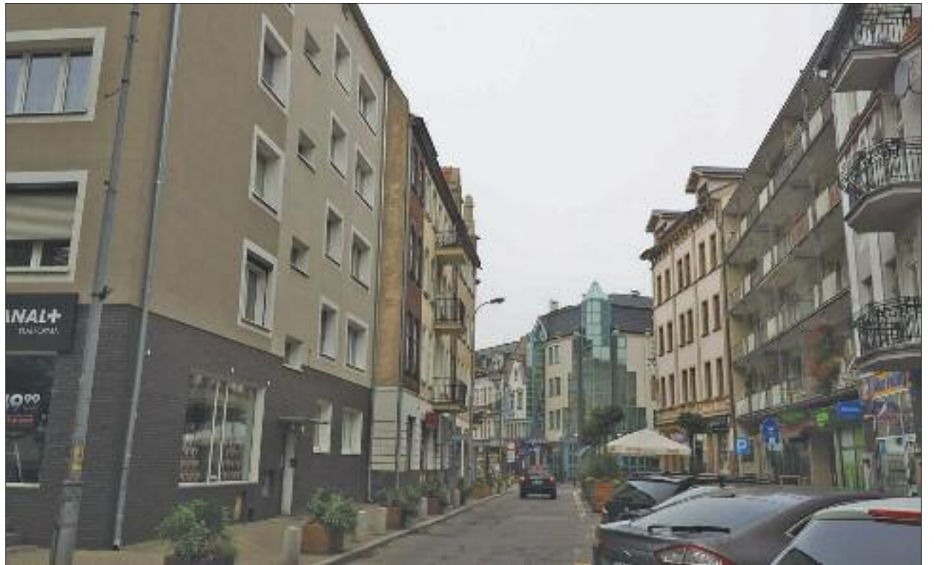
ZGM przeprowadzi w tym sezonie wiele prac dekarских, ogólnobudowlanych, elektrycznych oraz stolarsko-szklarskich
