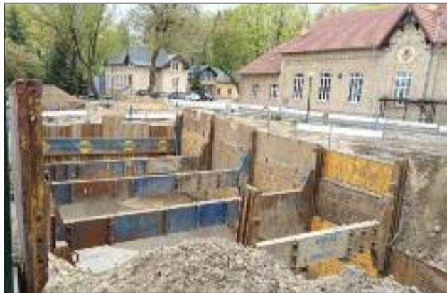
Dzięki budowie komory będzie łatwiejszy dostęp do całej armatury odcinającej i regulującej przepływ wody
