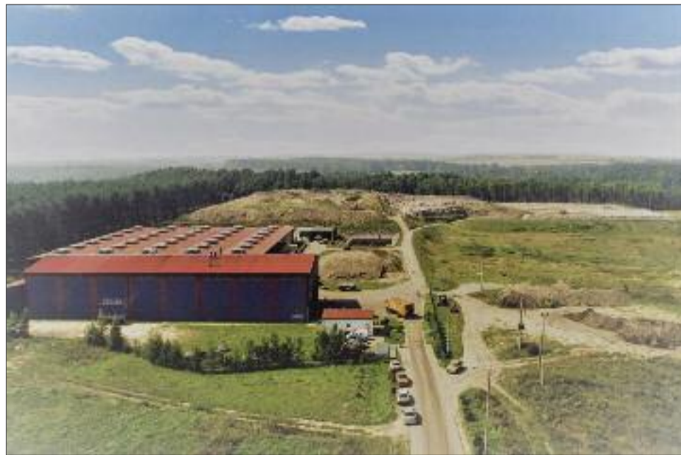
Regionalny Zakład Utylizacji Odpadów funkcjonuje od lat w Chróściku
