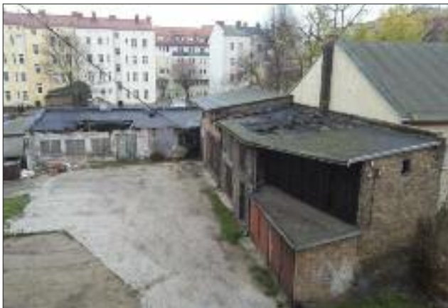
Przewidziane do rozebrania obiekty nie były poddawane już żadnym remontom
