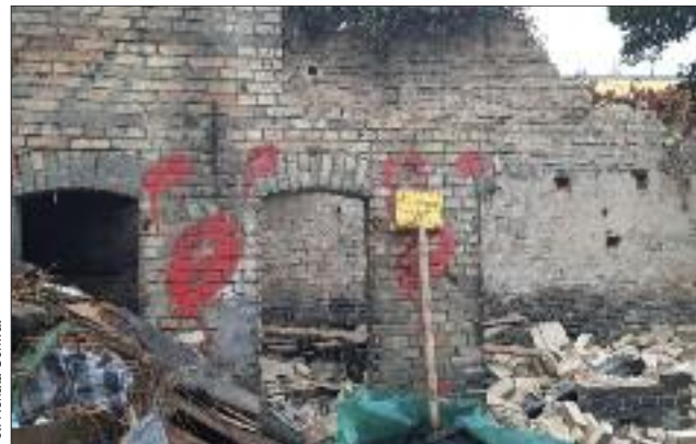
Podczas rozbiórki pokazało się, jak bardzo zniszczone te pomieszczenia były
