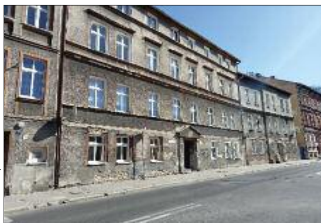
Jednym z budynków przygotowywanych do remontu jest ten przy ul. Drzymały 32
