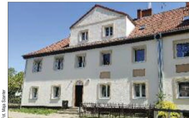
Budynek przy Chopina 16 po remoncie prezentuje się efektywnie
