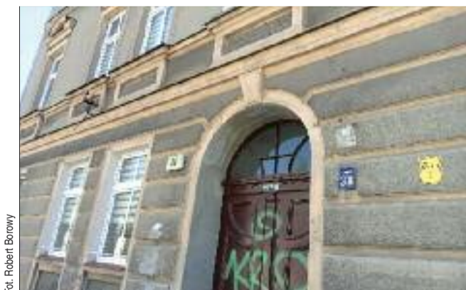
Niedługo kamienica przy Teatralnej będzie wyglądała jak nowa
