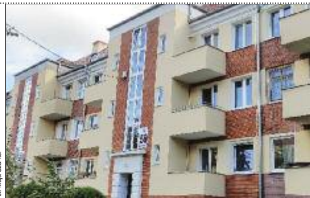
Budynek przy Chopina 58 po remoncie
