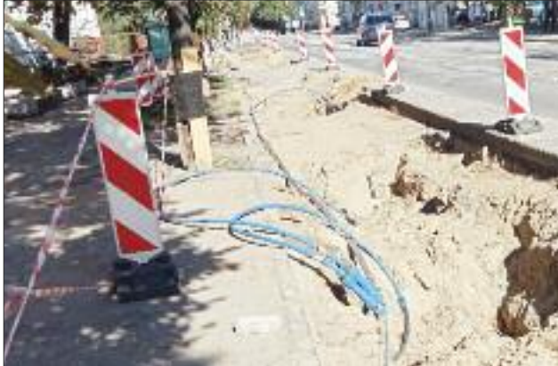
Prace z wymianą sieci wodociągowej powoli dobiegają końca
