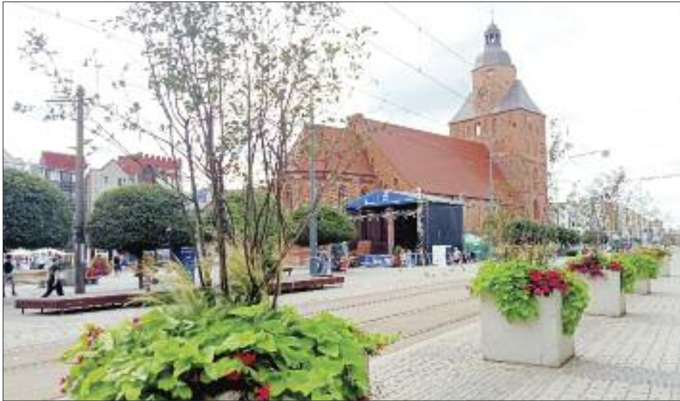
Budowa betonowego deptaku przy Katedrze od początku wzbudzała spore kontrowersje
