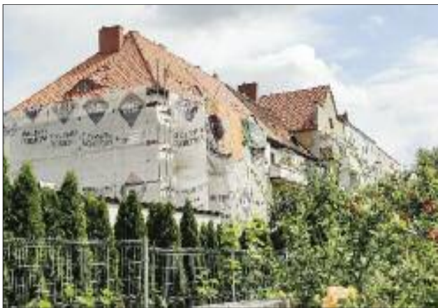
Przy ul. Śląskiej 18 powoli dobiega pierwsza część remontu, na drugi na razie mieszkańcy czekają
