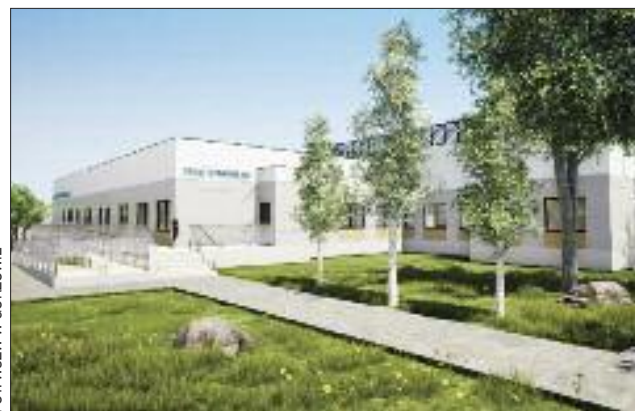
Jedną z trwających inwestycji to budowa Centrum Usług Diagnostycznych. Zastąpi ono dawne parterowe pawilony z lat 80.
