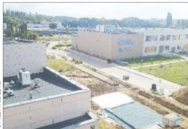
Problemy komunikacyjne przy Dekerta to efekt kumulacji inwestycji. Szpital przebudowuje drogi i chodniki, remontuje podziemne tunele, kończy budowę Centrum Usług Diagnostycznych i przebudowuje spalarnię
