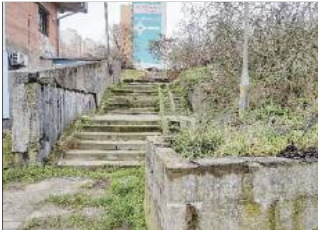
Likwidacja, a potem budowa nowych schodów to koszt rzędu 240 tysięcy złotych
