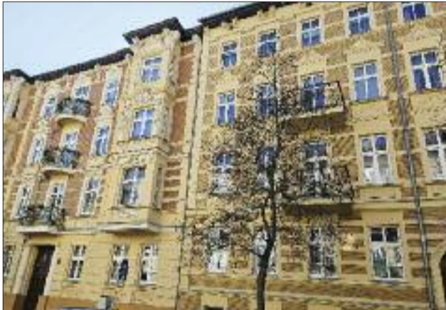
Fot. Robert Borowy Przy ul. Armii Polskiej w Gorzowie są perełki, ale są też kamienice wymagające szybkiej interwencji budowlanej. Co na to władze miasta, radni i konserwatorzy zabytków?
