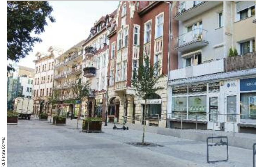
Prowadzone przez ZGM prace pozwalają usunąć drobne usterki i prawidłowo zabezpieczyć budynki przed zimą
