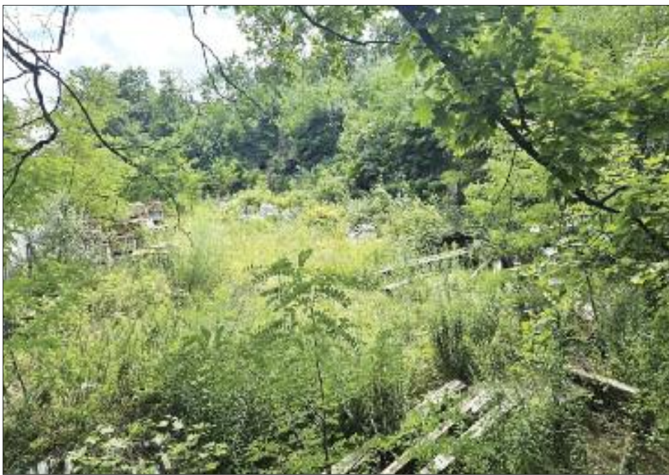
W wyniku interwencji konserwatora dzisiaj teren wygląda fatalnie i nie wiadomo, kiedy ruszą prace budowlane
