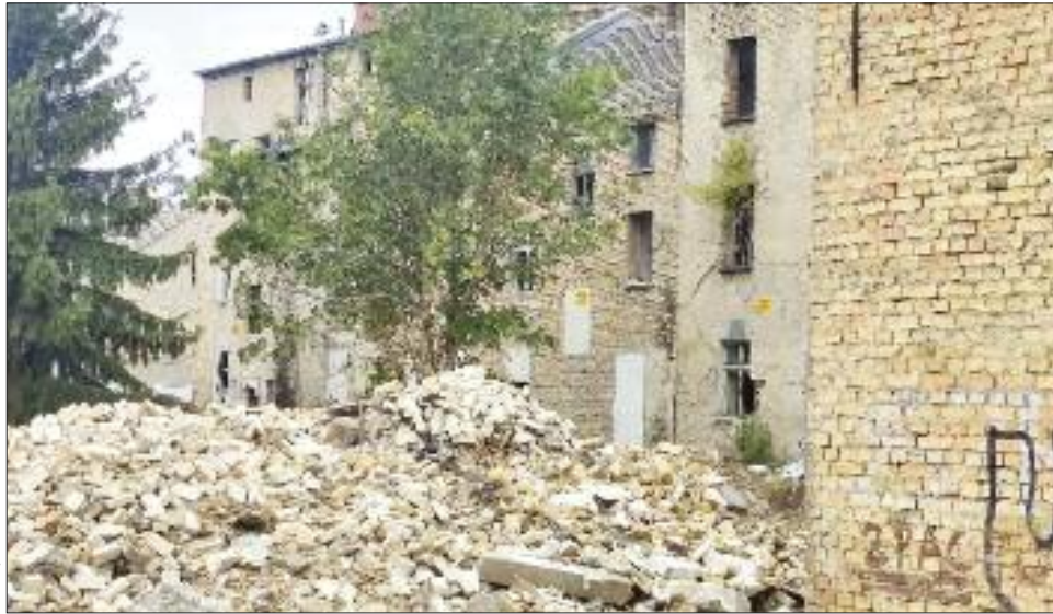
Powrócono do rozbiórki starych budynków przy ul. Przemysłowej i Prostej
