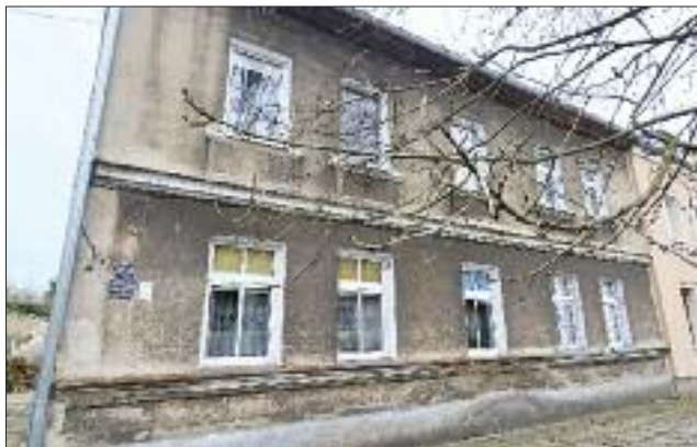
Za kilka miesięcy ten budynek przy ul. Spokojnej będzie już po kompleksowym remoncie
