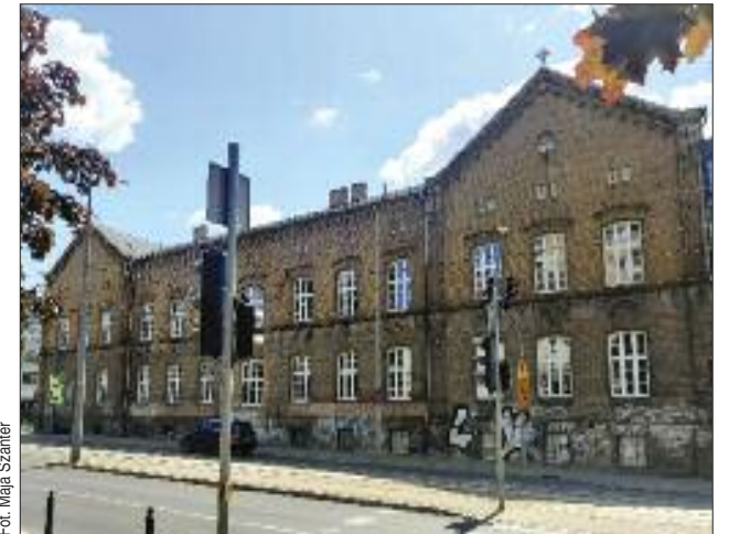
Ministerstwo zapewnia, że ma w planie renowację elewacji budynku przy ul. Warszawskiej
